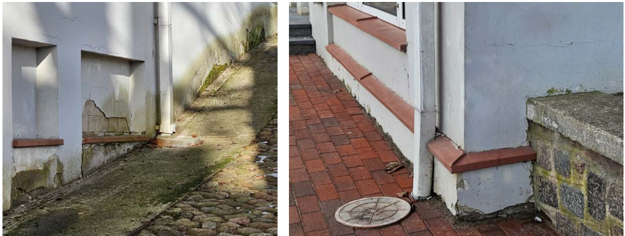
1 pav. Pastato cokolio ir nuogrindos fotofiksacijos
